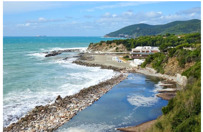
Vista delle strutture balneari e del porticciolo alla foce del Chioma. In primo piano la diga a protezione della costa
