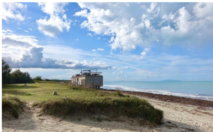
Duna rimaneggiata e costruzione recente sulla spiaggia
