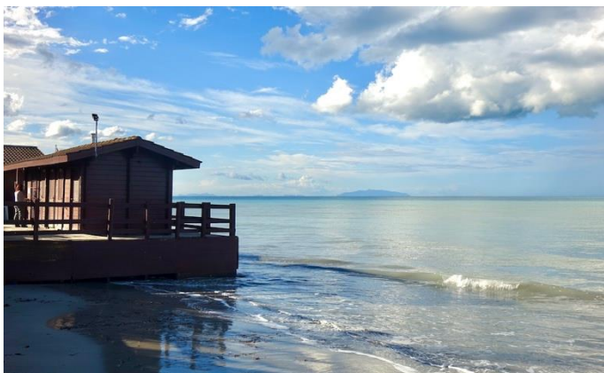
Strutture balneari esposte alle mareggiate
