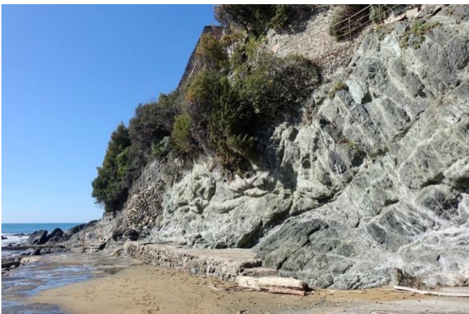
La falesia mostra le rocce ofiolitiche del basamento e la difficoltà di insediamento della vegetazione.
