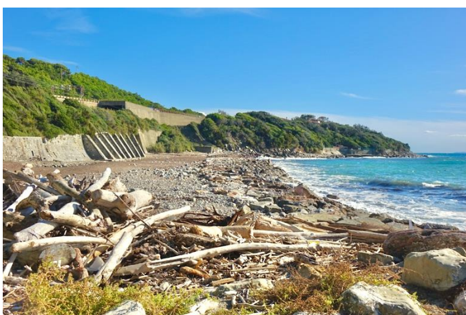
La costa soggetta all'erosione e le opere di difesa
